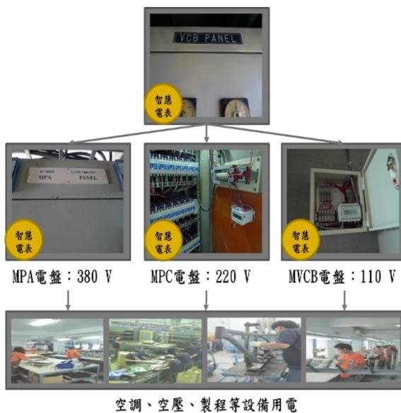
圖 1 建置智慧監控系統
